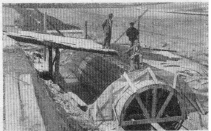
9. A baroki csőáteresz mintadeszkázata és szerelése.
