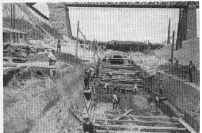
7. A baroki csőáteresz alapozása.
