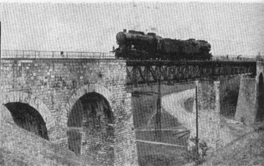
2. A helyreállított torbágyi híd próbatelhelése.
