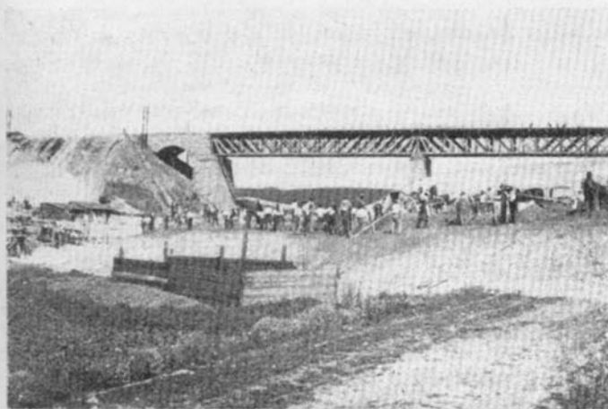
A baroki völgy áttöltésének munkája megkezdődik. A MÁV építkezése. Építette Fábián Lajos váltalkozó mérnök.
